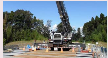
鋼殻パネル上からの架設状況
