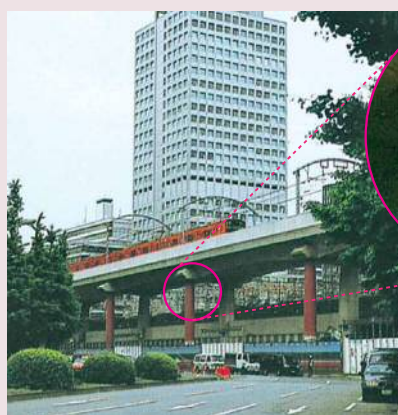
● 東京駅丸の内側(エンタシス状鋼管化粧板)
